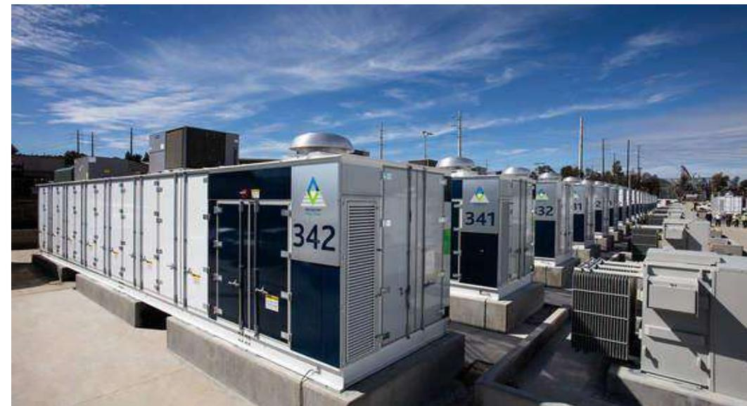
*Parte de un sistema de almacenamiento de energía de batería de iones de litio de 30 MW en Escondido, California.*
